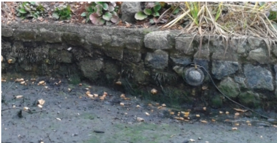
OSVĚTLENÍ - VĚNOVAT ZVÝŠENOU OPATROST PŘI OPRAVÁCH BŘEHU! DEMONTOVAT, VYČISTIT, USKLADNIT, PO DOKONČENÍ PRACÍ VRÁTIT ZPĚT.
