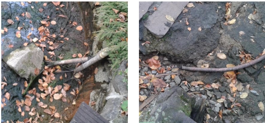
KABELY - V JEZÍRKU I MIMO NĚJ VÉST VE VODOTĚSNÉ CHRÁNIČCE! Z JEZÍRKA VYVÁDĚT PROSTUPEM V ŽIDCE A DÁLE PAK POD TERÉNEM.
