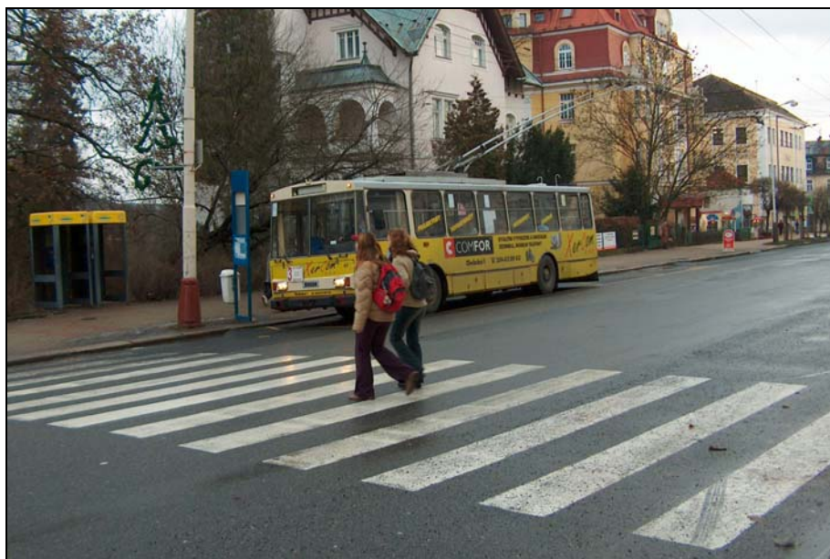
Obr.32: Zastávka MHD u knihovny je umístěna nebezpečně před přechodem pro chodce. Platí pro oba směry. Poznámka: v roce 2005 je plánována rekonstrukce celé křižovatky včetně přemístění zastávek.
