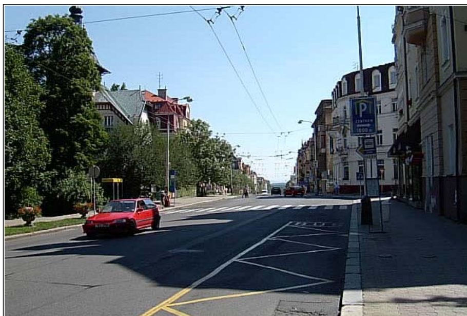
Obr.36: Hlavní ulice – přechod pro chodce u knihovny – šířka komunikace a tudíž i délka přechodu pro chodce 13 m prodlužuje dobu pobytu chodce v jízdnicích a výrazně zvyšuje nebezpečí vzájemného střetu. Místo s častými dopravními nehodami.
