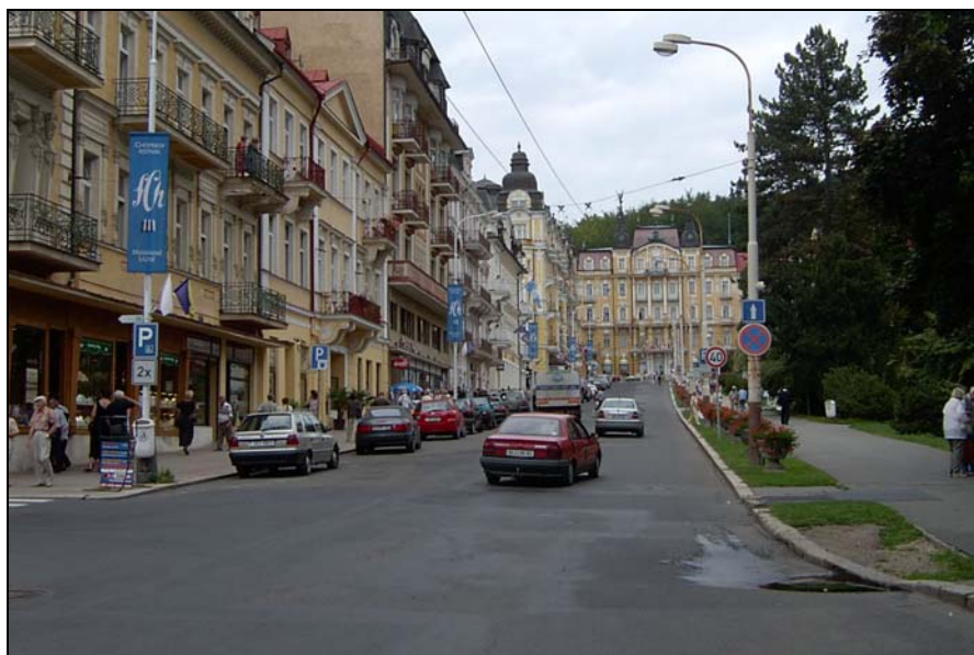
Obr.23: Hlavní ulice u křižovátky s Ruskou ulicí – široká vozovka umožňuje jízdu vysokou rychlostí, auta zabírají nadbytečně mnoho uličního prostoru na úkor zeleně a chodců
