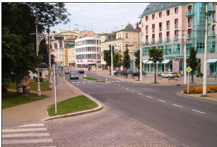
Obr.34: Přechod pro chodce se středním dělicím ostrůvkem byl realizován na Hlavní ulici u hotelu Cristal v roce 2004 jako pilotní ukázka opatření ke zvýšení bezpečnosti přecházejících chodců.
