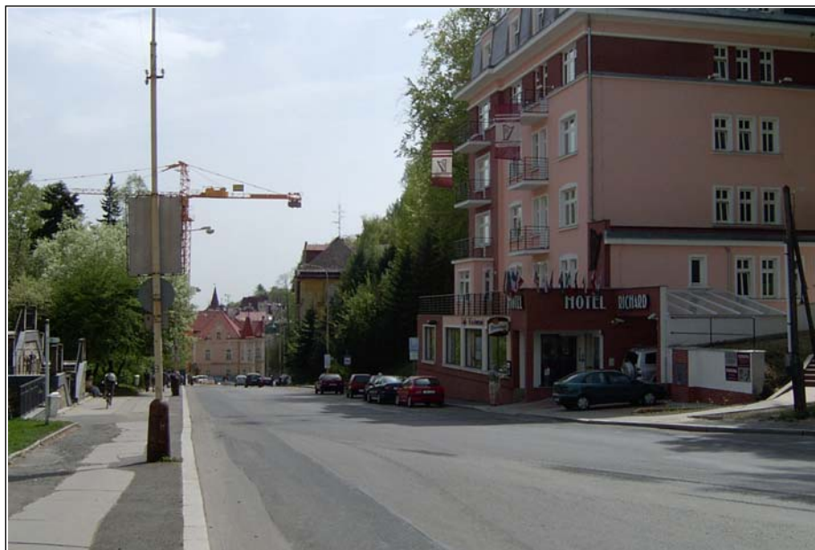
Obr.35: Ruská ulice – ukázka místa s chybějícím přechodem pro chodce. Široká komunikace navíc „nabádá“ řidiče k jízdě vysokou rychlostí. Viz také místo se scházejícím přechodem u spořitelny na obr.22)
