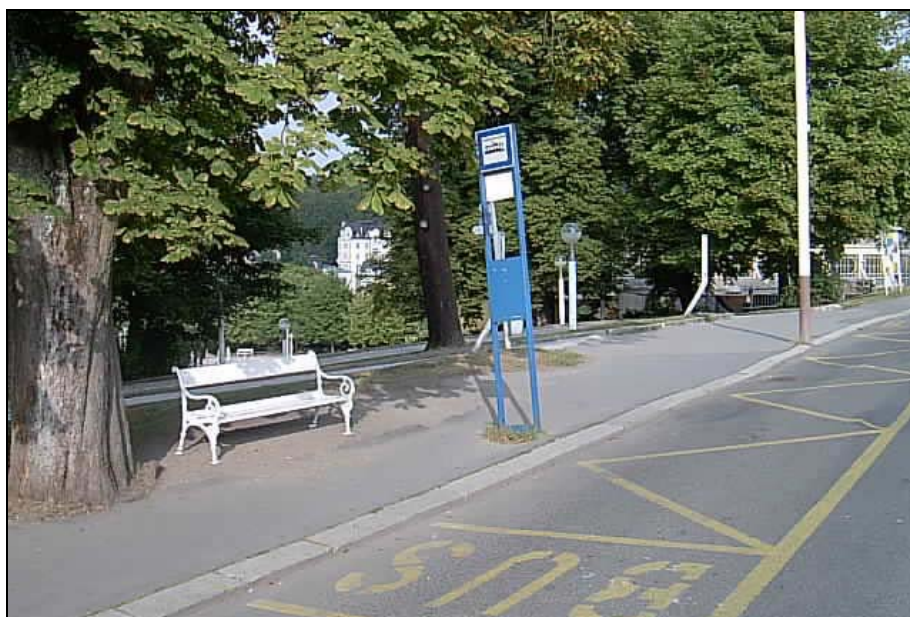
Obr.33: Zastávka MHD na Goethově náměstí je ukázkou nevyhovujícího technického stavu zastávky: nízká nástupní hrana, nedostatečná šířka nástupiště, chybějící přístřešek a navíc sloup troleje umístěný přímo v místě výstupu ze zadních dveří vozidla.
