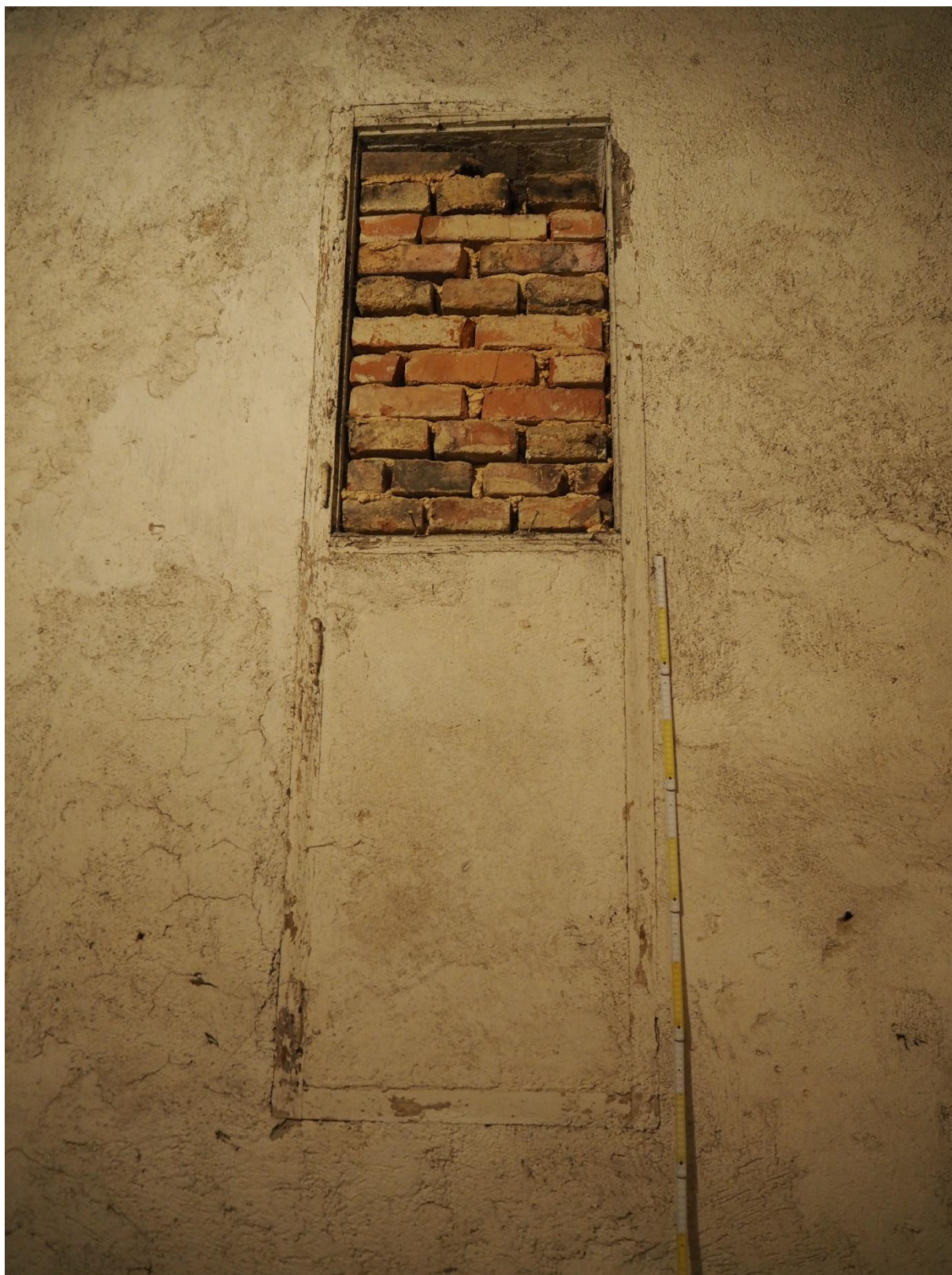
Obr. 48: Zazděný okenní otvor s rámem v jižní stěně místnosti S.73.
