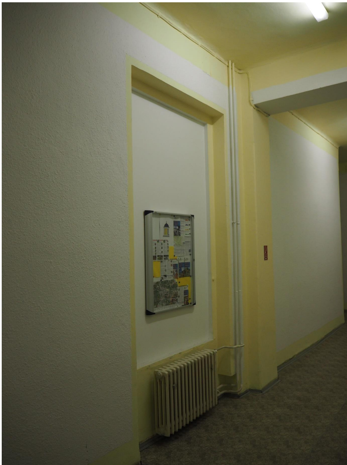
Obr. 88: Slepá okenní nika v jižní stěně středního dílu chodby 1.40a původně vedoucí do světlíku SV.02.
