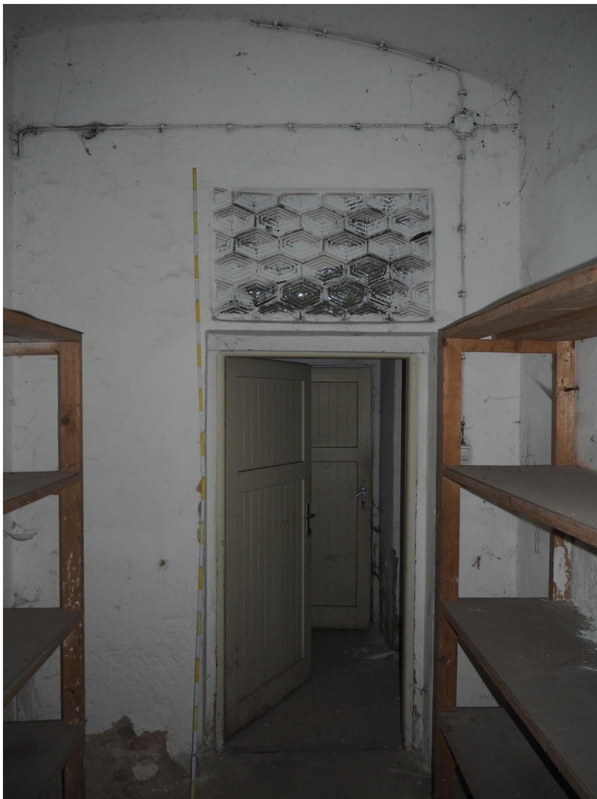
Obr. 77: Severní stěna místnosti S.39 s dveřmi s nadsvětlíkem ze šestiúhelníkových sklobetonových tvárnic.
