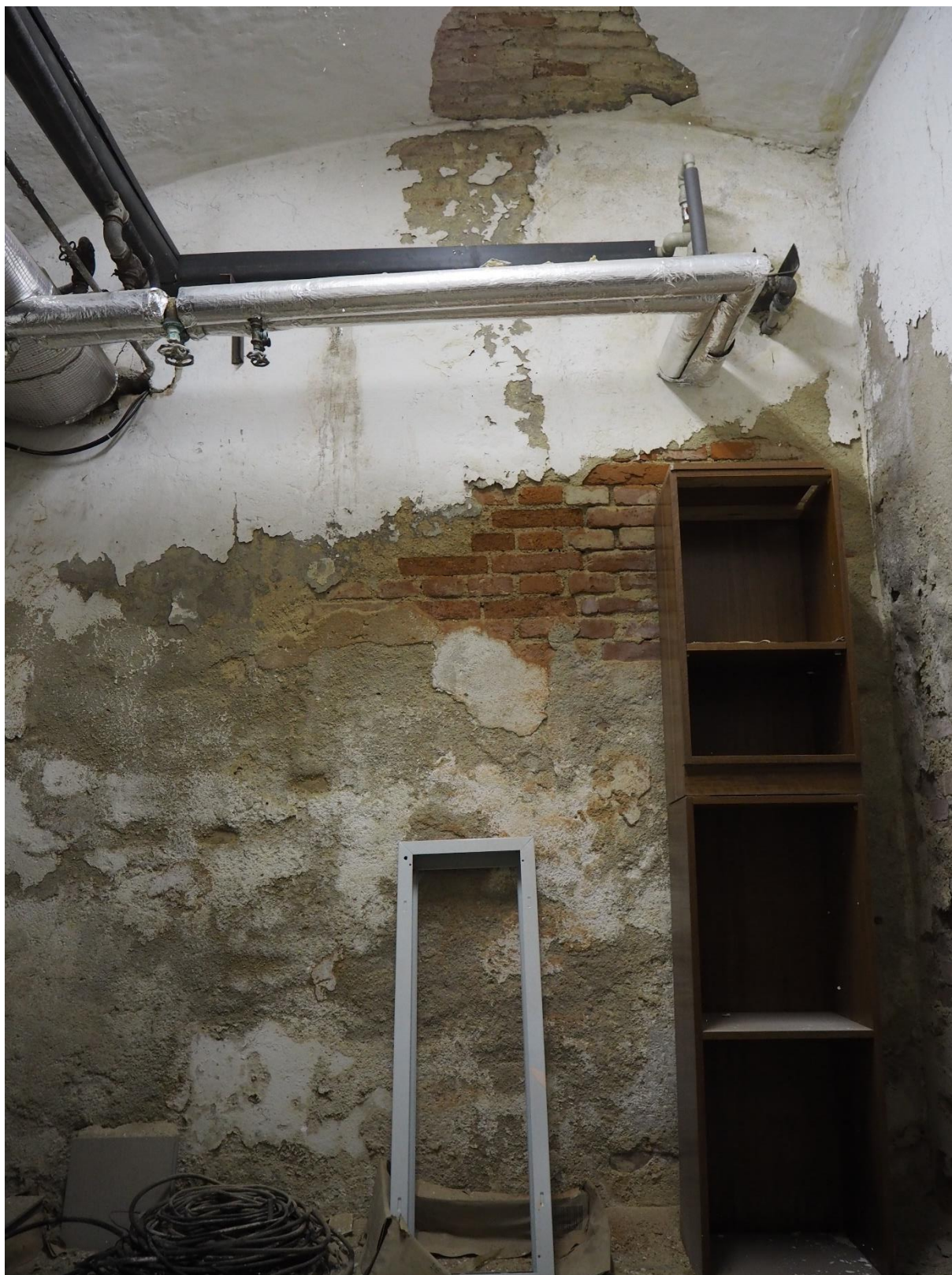
Obr. 50: Jižní stěna místnosti S.75. Patrné je asymetrické čelo klenby - vestvba vzduchotechniky k západní stěně.
