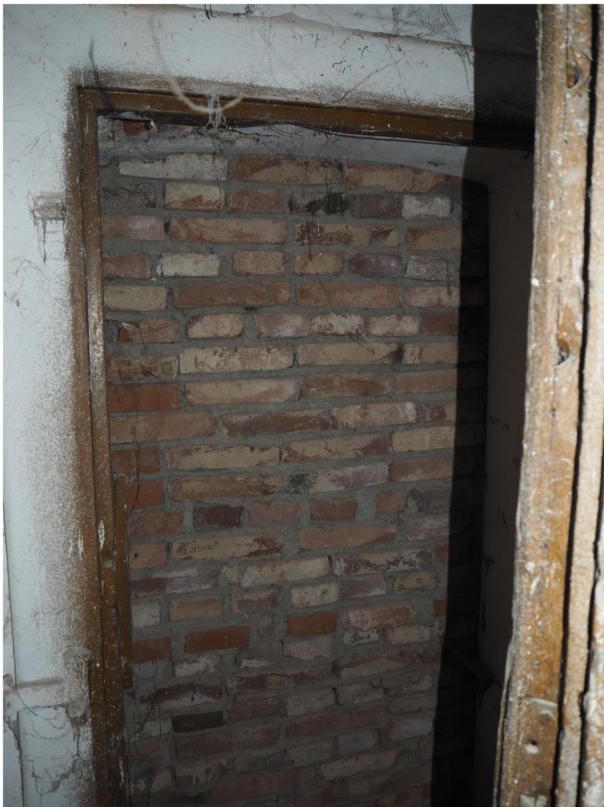
Obr. 80: zazdívka dveřního otvoru v jižní stěně místnosti S.14.
