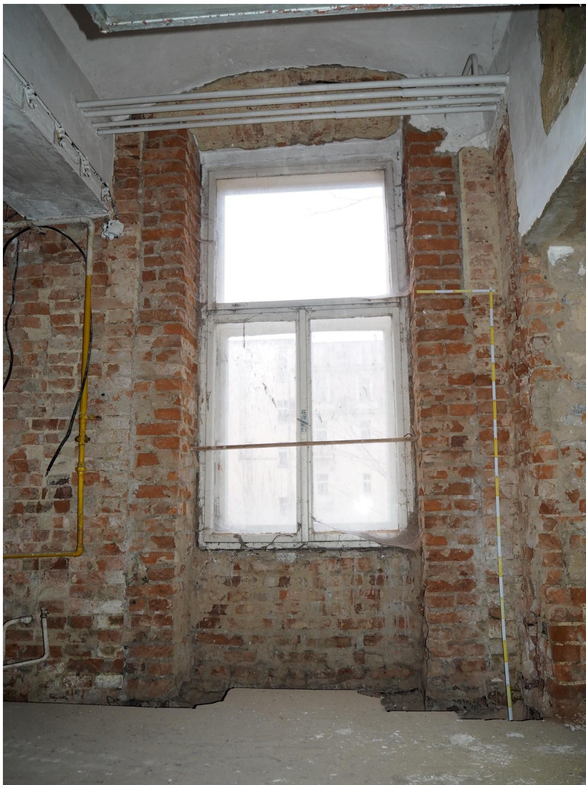
Obr. 70: Zazděný dveřní otvor ve východní stěně místnosti S.27.
