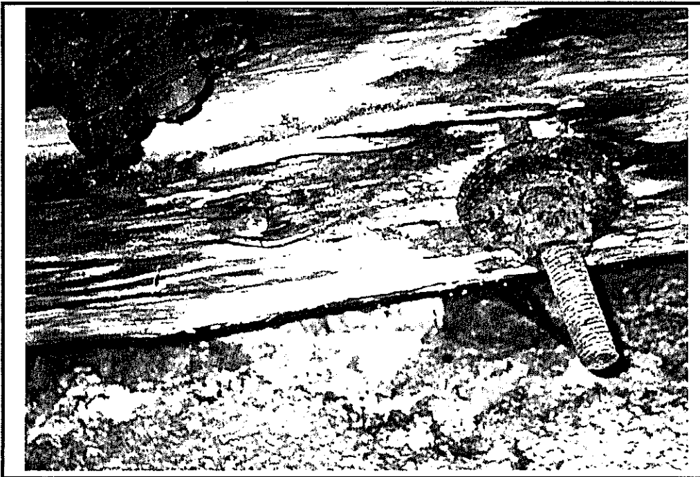
Foto č. 20 JV krov, lokalita 12: Silná destrukce krokve u komína v důsledku zatékání
