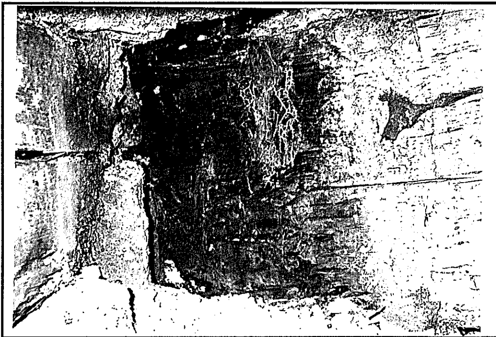
Foto č. 3 Krov věže, lokalita 5: Totální destrukce zhlaví vazného trámu dřevomorkou
