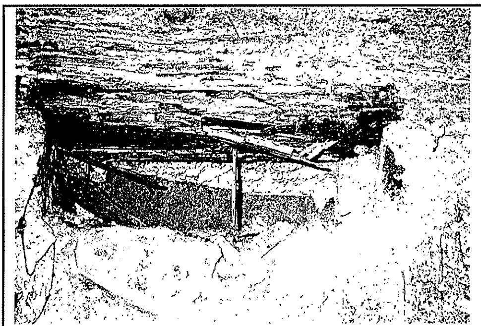
Foto č. 8 SV krov, lokalita : Totální destrukce pozednice po vyjmutí cihly
