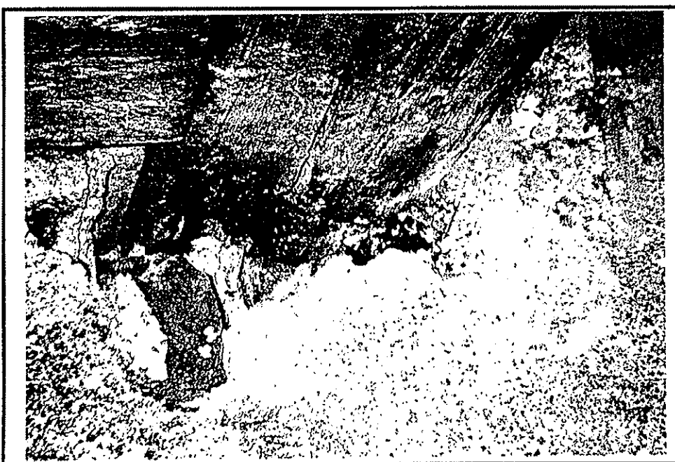
Foto č. 18 JV krov, lokalita 2: Totální destrukce zhlaví vazného trámu
