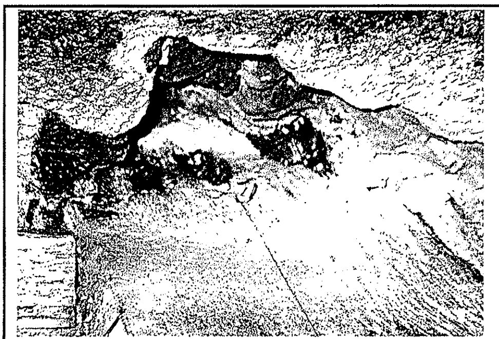
Foto č. 14 JZ krov, lokalita 2: Totální destrukce zadní části zhlaví vazného trámu
