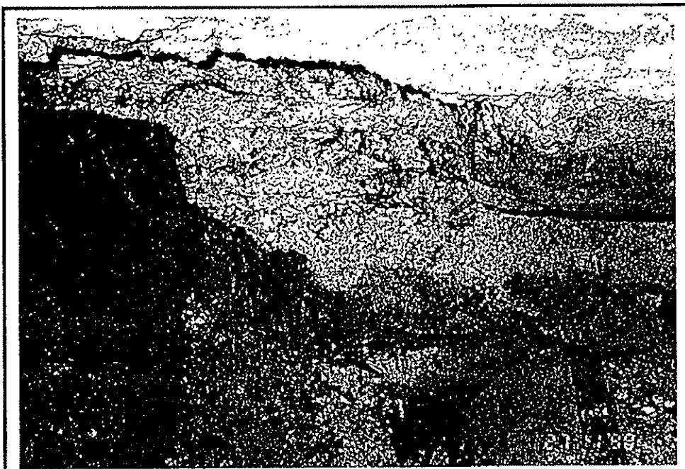
Foto č. 7 Kapsa zdiva ( trám č. 1 velká místnost ) prorostlá myceliem dřevokazné houby
