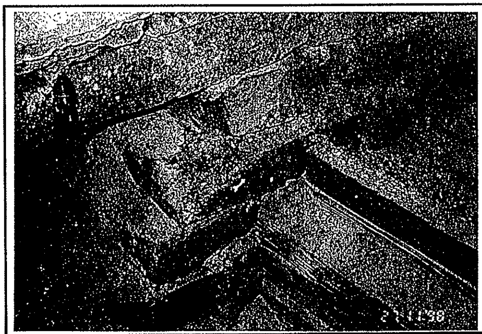
Foto č. 8 Spáry prorůstající myceliem houby
