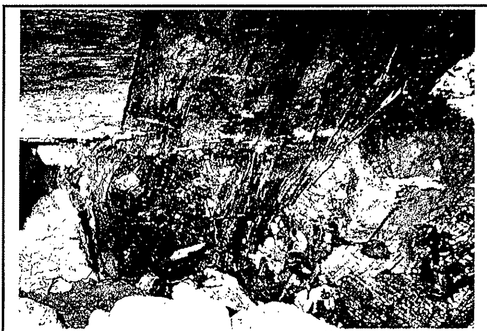
Foto č. 16 JZ krov, lokalita 5: Totální destrukce zhlaví vazného trámu
