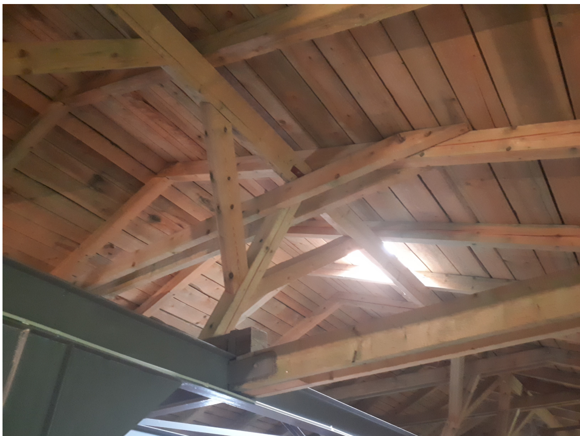
Obrázek č.3 – foto krovu – část plné vazby
