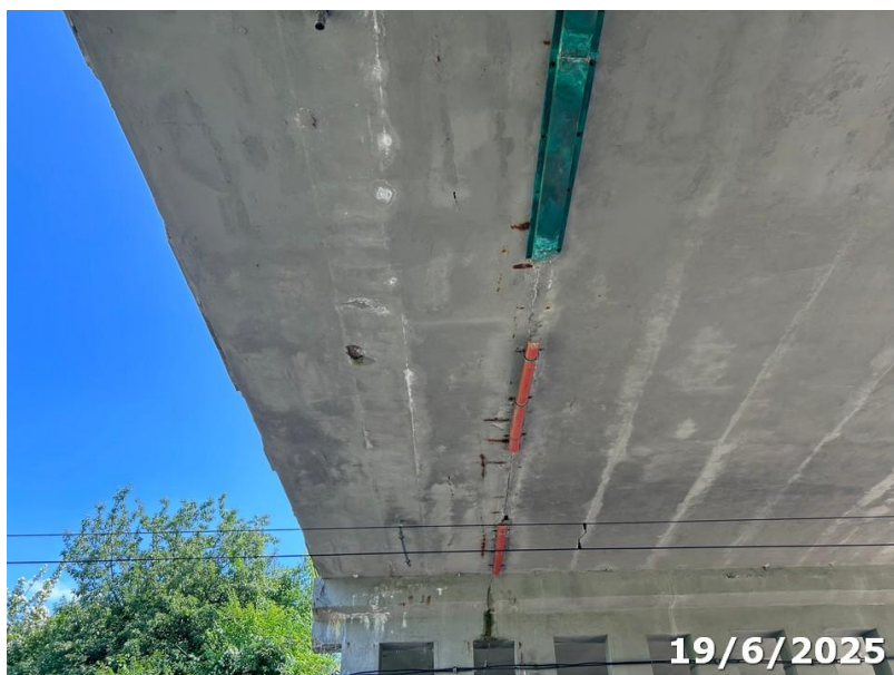
Obr.21 Podhled pole 2, pravý okraj (pohled proti směru staničení)
