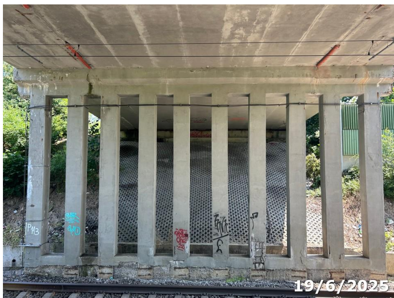
Obr.10 P2, pohled proti směru staničení
