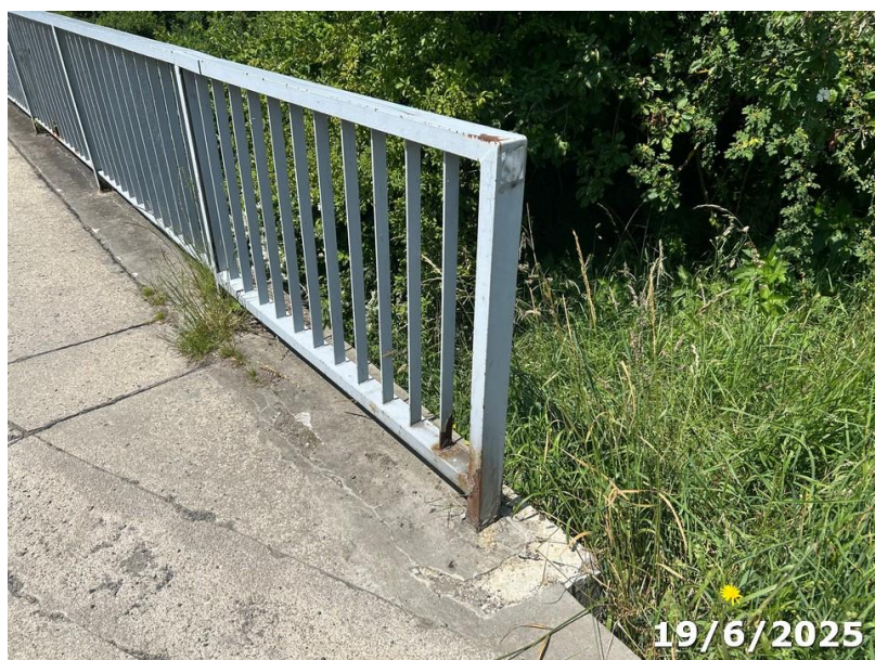
Obr.31 Zábradlí, koroze
