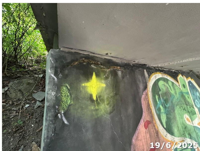
Obr.17 OP4, levý okraj, trhlina v líci pod uložením nosníků
