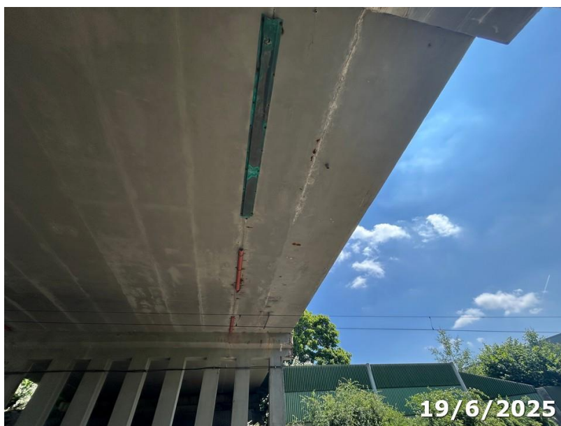
Obr.20 Podhled pole 2, levý okraj (pohled proti směru staničení)
