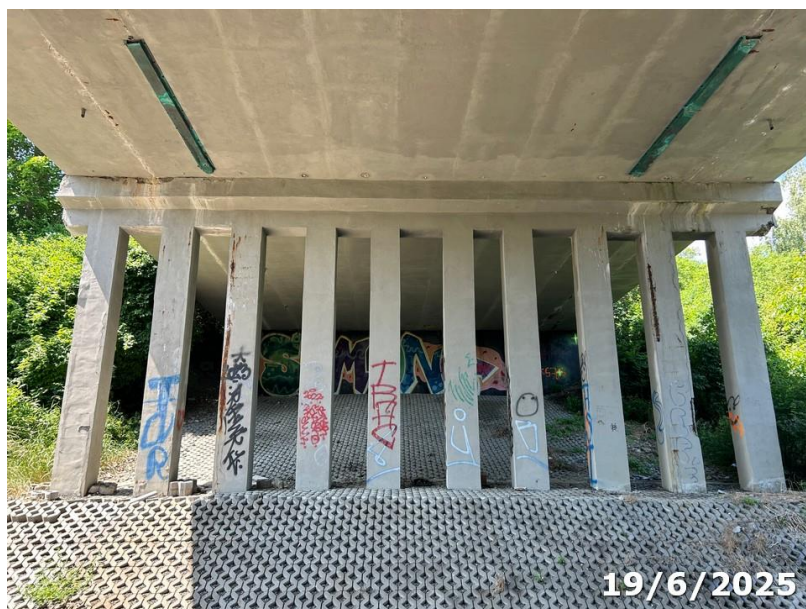
Obr.13 P3, výluhy pojiva na stativěch
