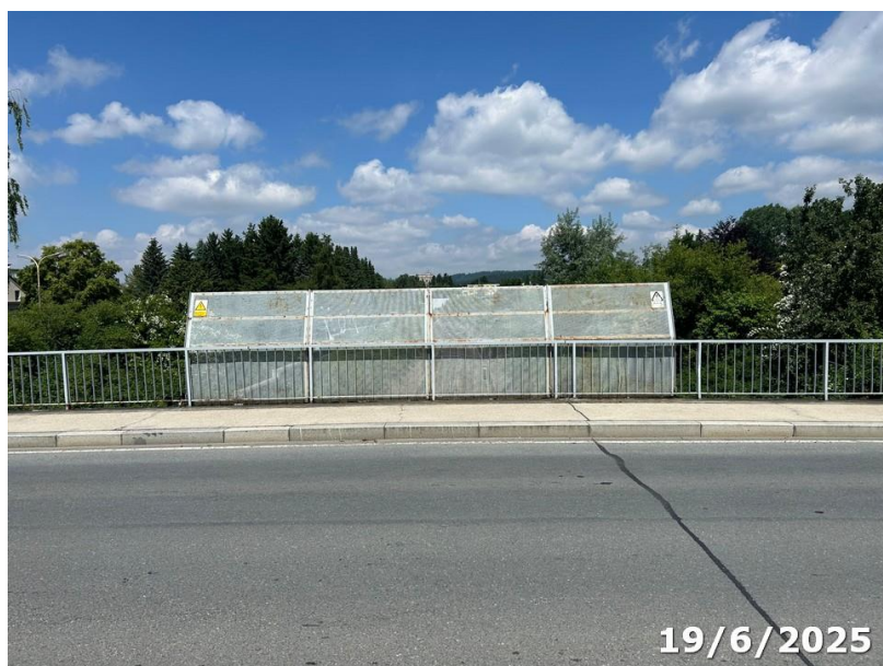
Obr.34 Protidotyková zábrana vpravo
