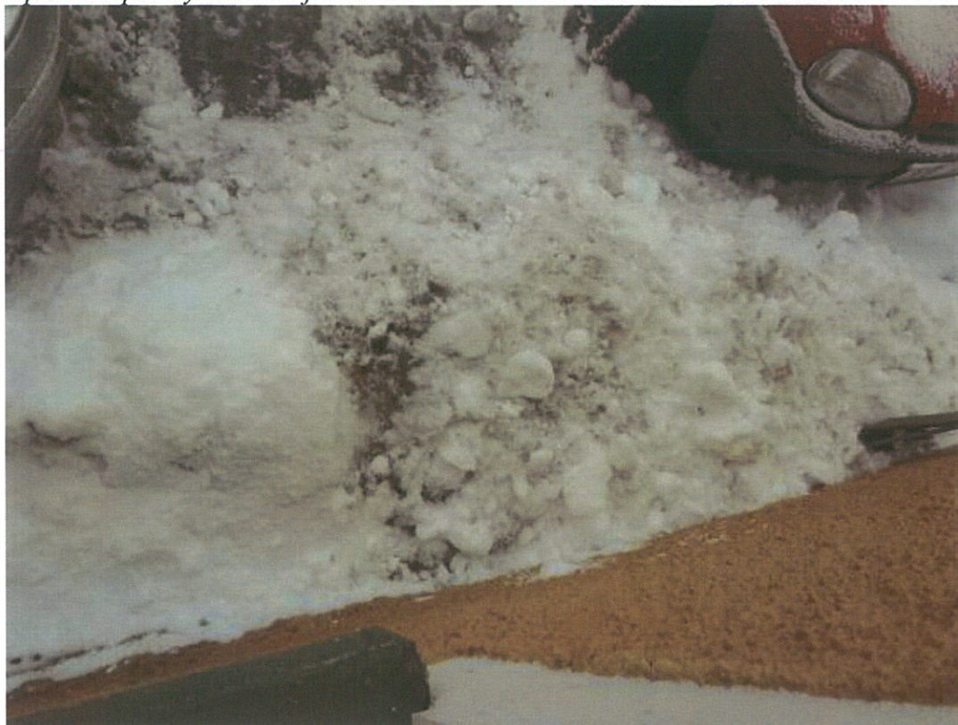
Foto č.10 – zpevněné plochy kolem objektu
