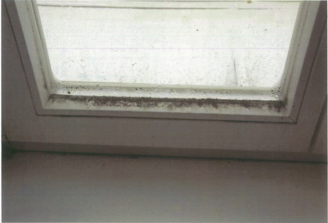
Foto č.4 – okenní zasklívací lišty
