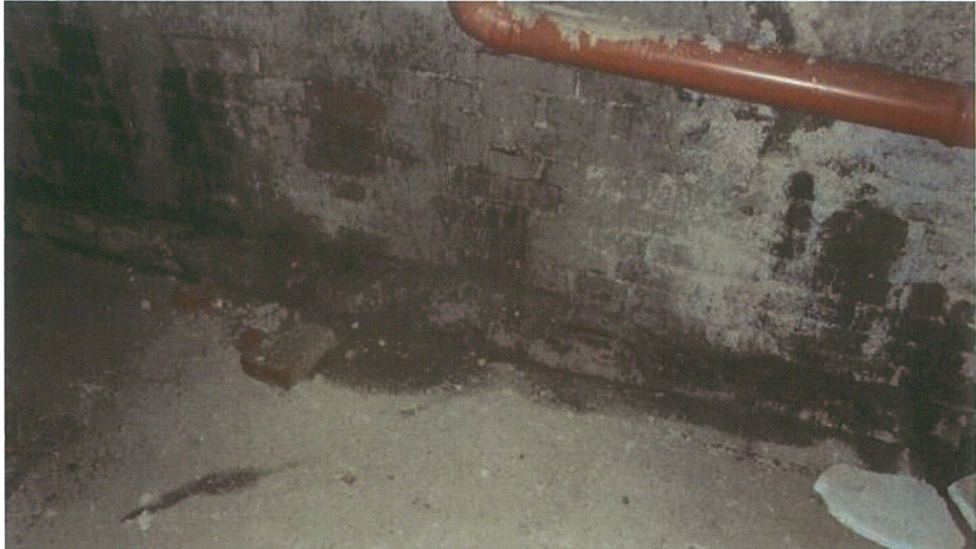
Foto č.11 – suterénní zdivo
