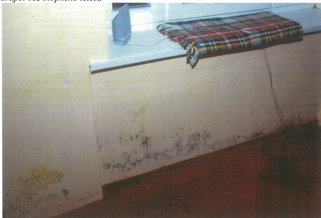
Foto č.6 – parapet bez otopného tělesa
